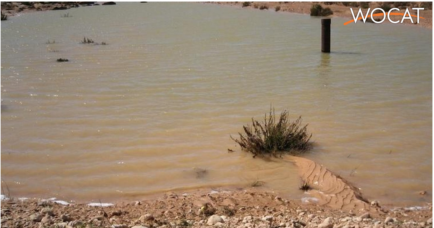
Recharge well derrière un barrage de gabions après la tempête. (Ouessar M (Medenine, Tunisia))
