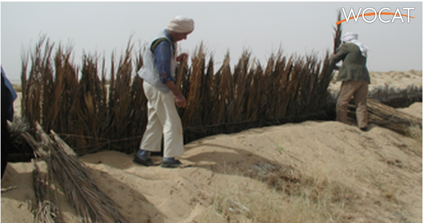
Chantier de rehaussement des palissades en feuilles de palmes pour la fixation des sables Mobiles à Tozeur - Tunisie (Taamallah Houcine)
