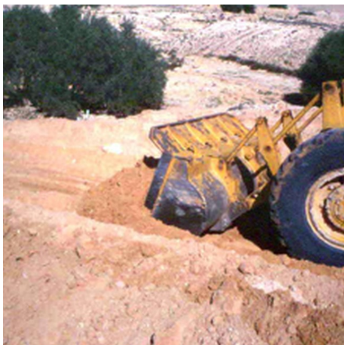
Chantier de création mécanique de Tabia dans la région de zone de Tataouine - Tunisie (Taamallah Houcine)
