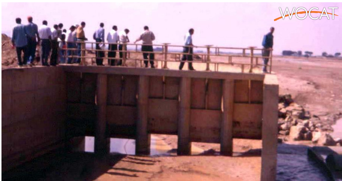
Vue d'ensemble d'un Mgoud construit avec du béton avec plusieurs ouvertures dans la zone de Sidi Bouzid – Tunisie. (Mohamed Ouessar)
